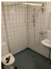
Eksisterende badeværelse med fliser, vinylgulv og svingarmatur
